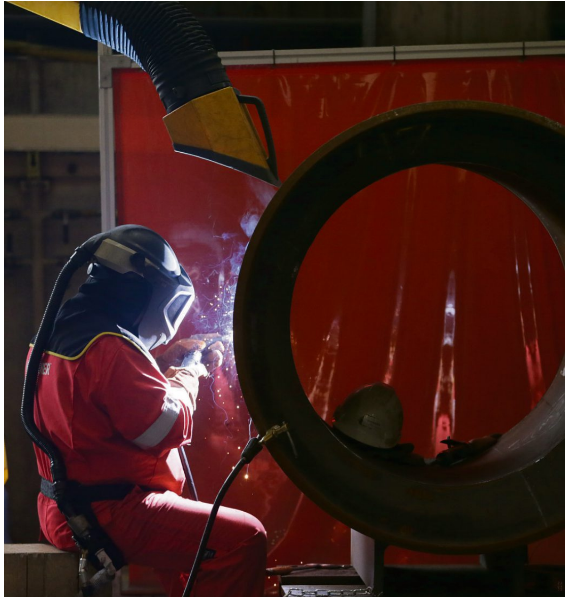
I neste uke avdukes et nytt klyngesamarbeid i Verdal med store ambisjoner. Suksessen til Kværner Verdal er lokomotivet for industrisamarbeidet i regionen. Foto: LEIF ARNE HOLME
